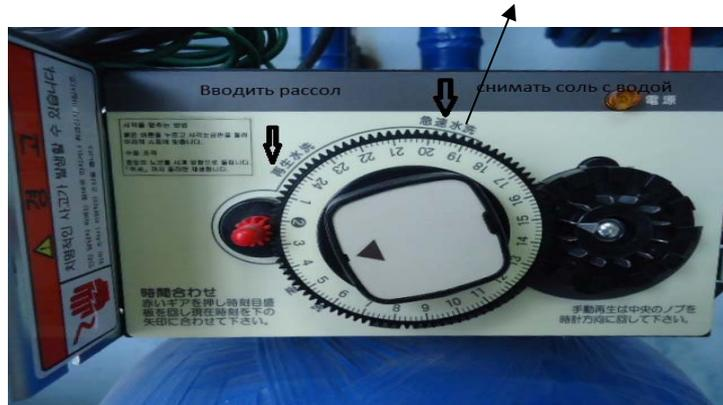
2) Проверьте вода пройдёт на дренаже, как «обратный поток:역세»
